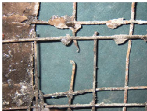
モルタルの壁は、ラス網という金網を下地にしてモルタルを塗って仕上げています。
